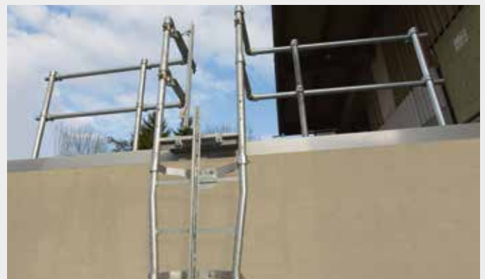
Ausstiegsgeländer (2 Sets) mit einschwenkbarer Einstiegshilfe
